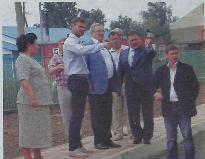
У строящегося детского сада
